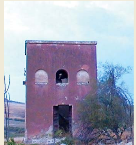
Borgo Guttadauro. La Centrale elettrica.
