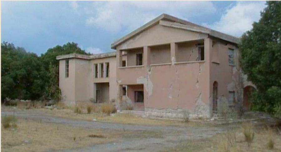
Borgo Guttadauro. La Caserma prospiciente alla piazza principale.
