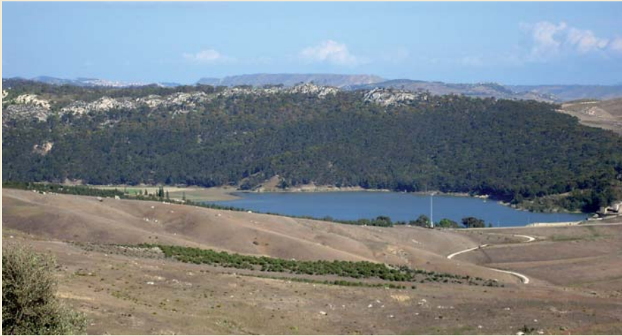
Diga Disueri nelle vicinanze di Borgo Guttadauro.
